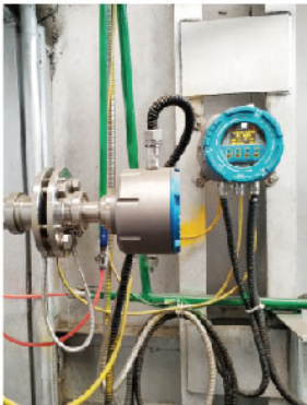
加热炉燃烧优化控制-- 高温1300°C(O 2 )
