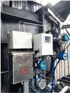
干熄焦余热回收过程监测 (原位激光CO\CO 2 \O 2 )
