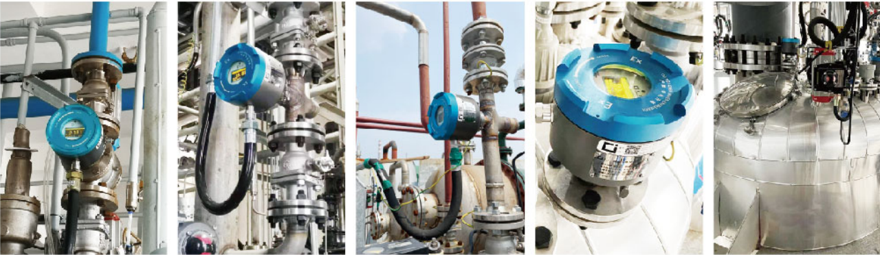
氨基化反应釜过程(O 2 ) 强酸碱工艺离心机过程 氯甲烷回收工艺监测 固体粉料反应釜 (釜顶安装) 加氢反应釜过程
